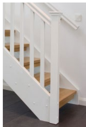
Traditionellt montage med täckplugg på utsida vangstycke
