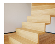
Tät trapp med nollöverlappning
