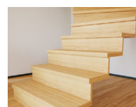
Tät trapp med överlapp 30 mm
